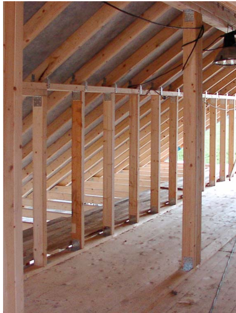
Komplettsanierung eines Fachwerk-Dachstuhls.
