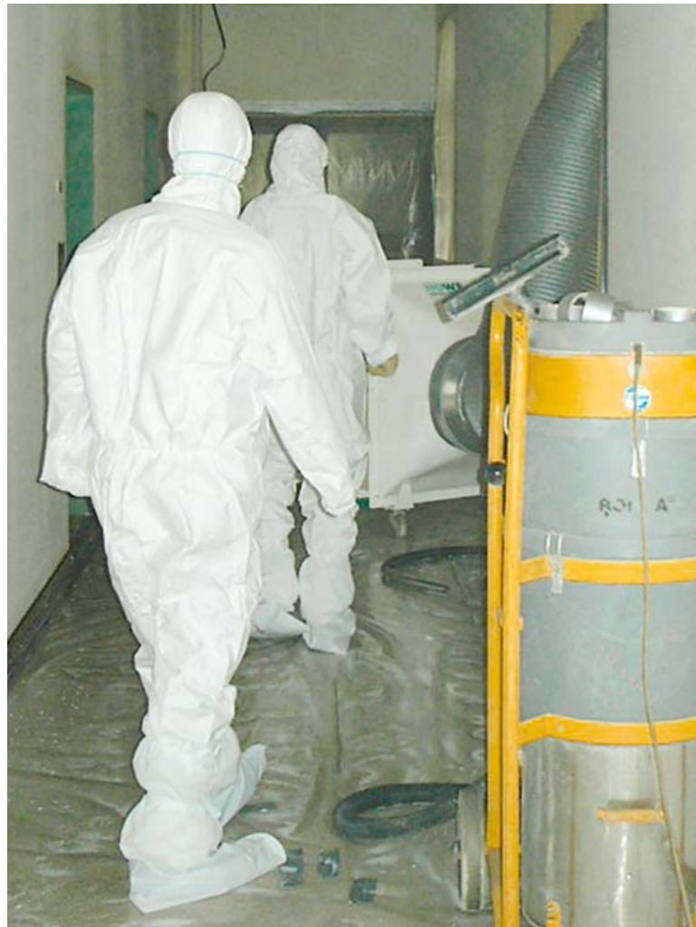
Arbeitsvorbereitung nach einem Brandschadensfall.
