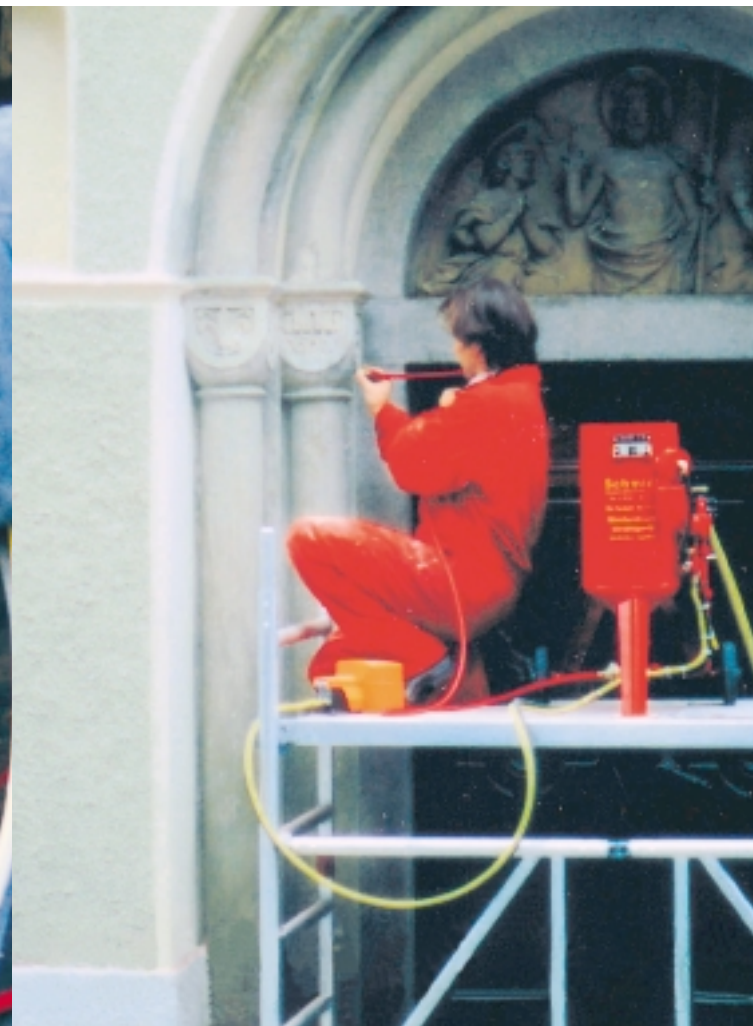
Sanierungsarbeiten am Eingangsbereich einer Kirche.
