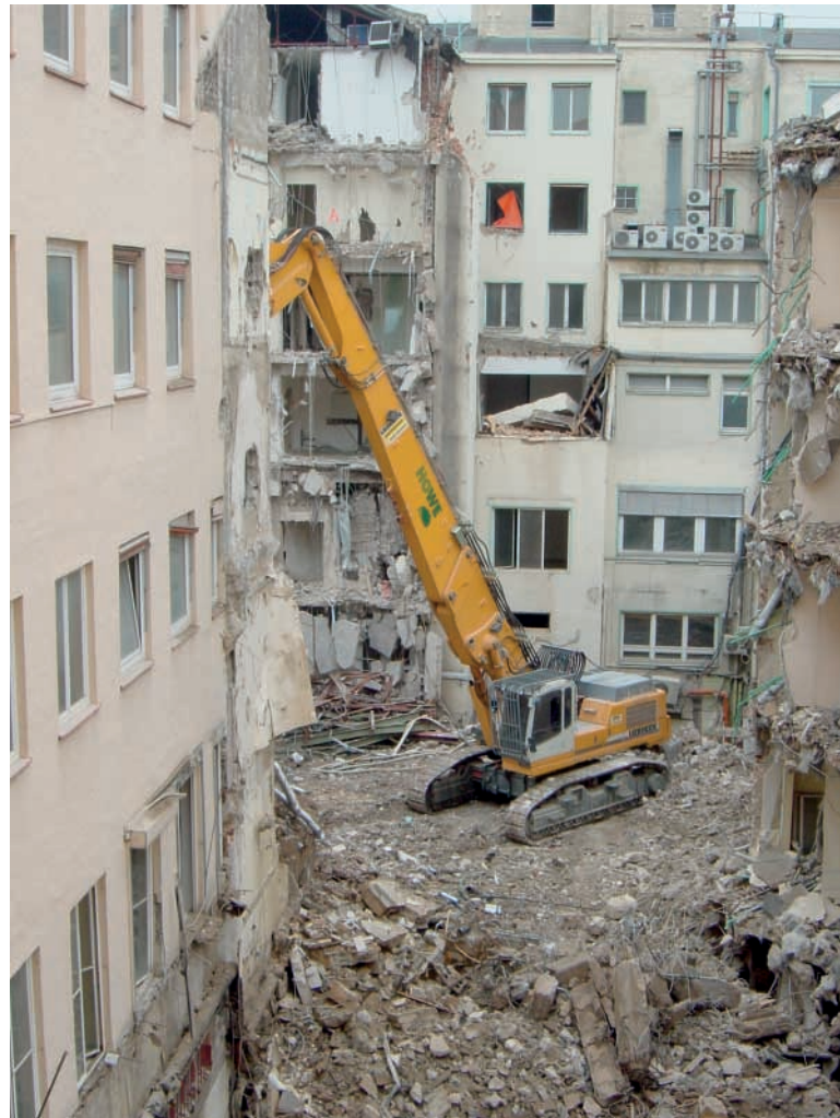
Langfront-Raupbagger im Einsatz.
